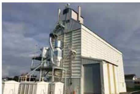
Les capacités de réception en bio ont été augmentées avec la conversion du silo « Henry » (capacité de 3 600 t). Ce silo offre une fosse de réception supplémentaire de déchargement, il est équipé maintenant d'un système de nettoyage performant.
